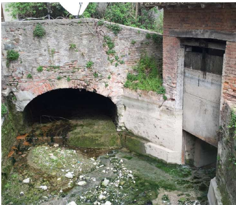
Scaricatore Rio Rocca – a sinistra la luce di ingresso del tratto di canale tombato oggetto di eventuali risanamenti locali; a destra lo scaricatore di fondo sul Rio Rocca.
