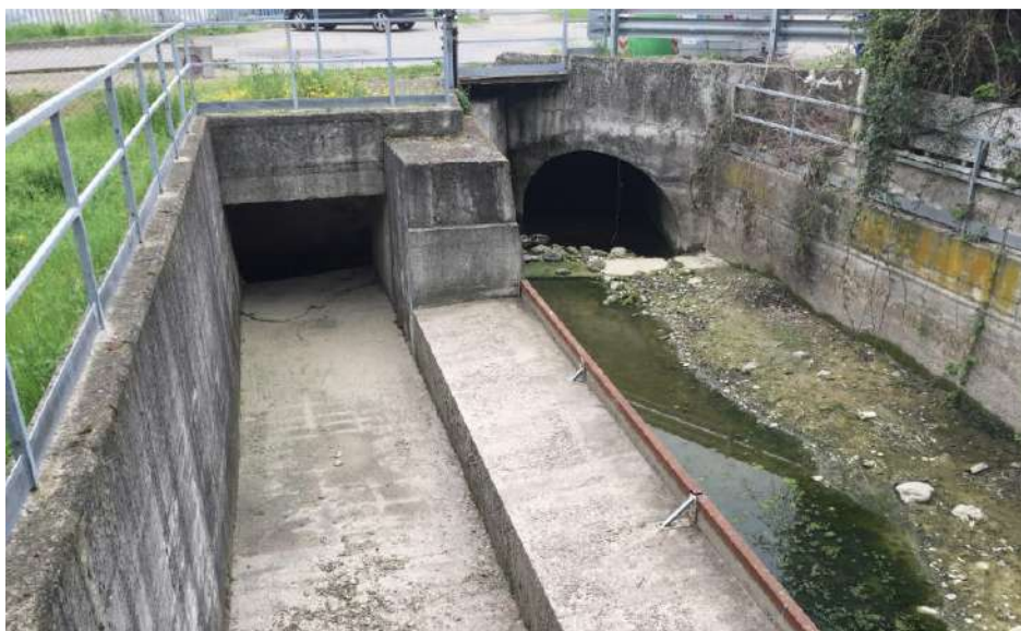
Vista da valle dello scaricatore Monte Arnone – sfioratore laterale
