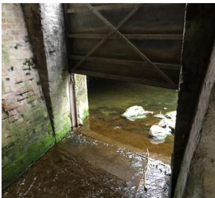
Scarico di fondo dello scaricatore – paratoia manuale da sostituire con paratoia automatica
